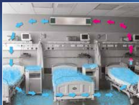
Proces oczyszczania powietrza promiennikami wewnętrznymi (powietrze)
